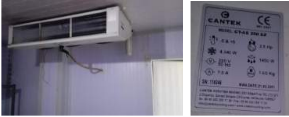
Fotoğraf 3. 107. Soğuk Hava Deposu Klima ve Etiket Bilgisi
