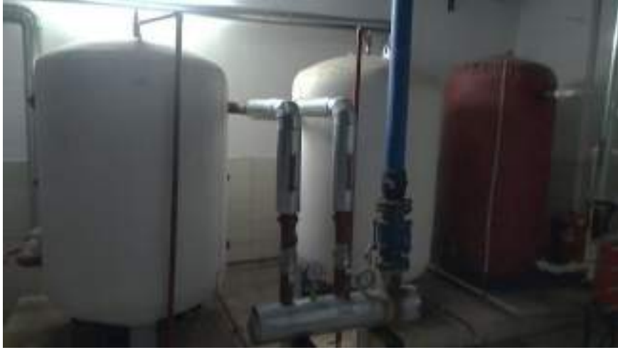
Fotoğraf 3. 41. Akümülayon Tanklarının Genel Görünümü
