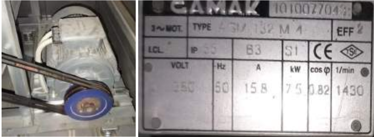
Fotoğraf 3. 92. EA-2 14.Blok Zemin ve 1.Kat Muayeneler KS Aspiratör Motoru ve Etiketi
