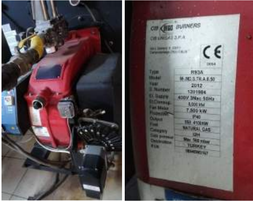
Fotoğraf 3. 35. Brülör Genel Görünümü ve Etiket Bilgileri
