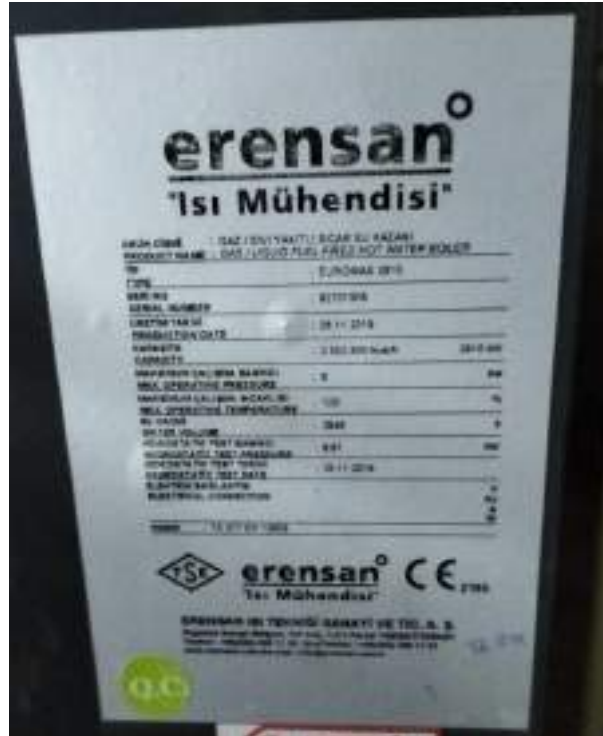
Fotoğraf 3. 34. Kazan-2 ve Kazan-3 Etiket Bilgisi
