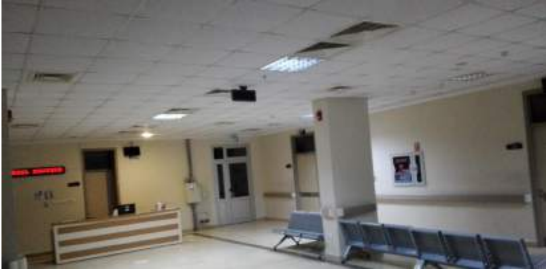
Fotoğraf 3. 99. 3.Kat Genel Cerrahi, Kalp Damar Cerrahisi, Göğüs Cerrahisi, Anestezi Poliklinikleri Bekleme Alanı- 4x18W Tüp Floresan Lambalı EB Kare Tip Armatürler
