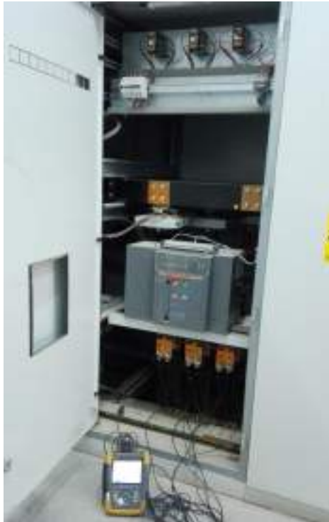
Fotoğraf 3. 81. Ana Dağıtım Panosunda Enerji Analizörü Ölçümleri
