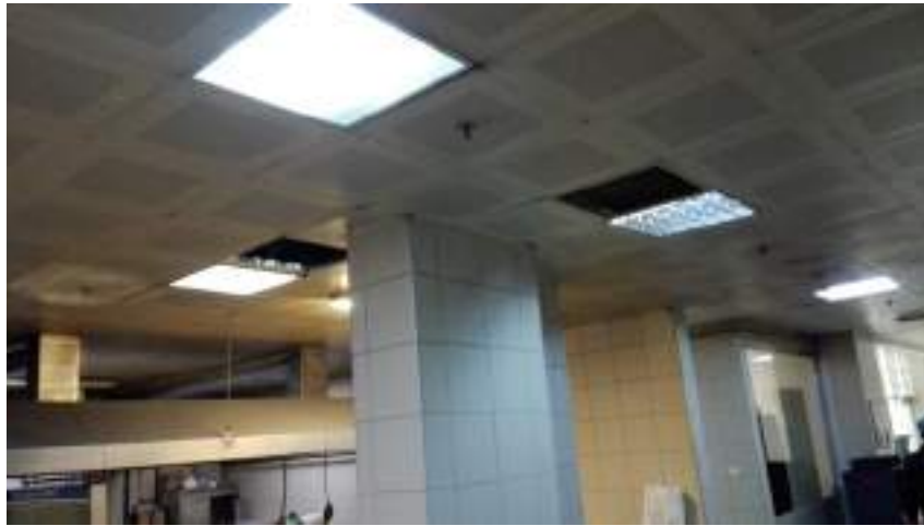
Fotoğraf 3. 101. Mutfak Bölümü-4x18W Tüp Floresan Lambalı EB ve 40W LED Kare Tip Armatürler
