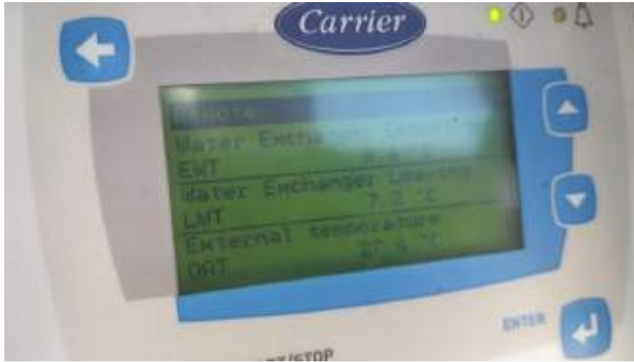
Fotoğraf 3. 50. Soğutma Grubu Giriş-Çıkış Sıcaklık Değerleri
