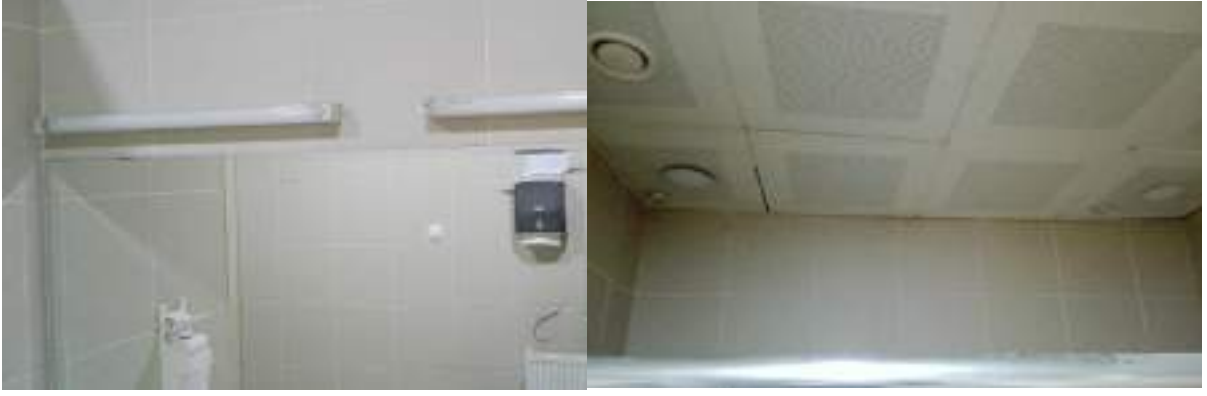
Fotoğraf 3. 102. WC'ler Bölümü-1x18W Tüp Floresan Lambalı EB Ayna Üstü ve 12W Ledli Downlight Armatürler
