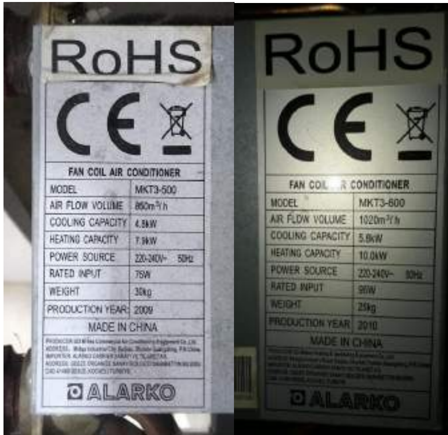
Fotoğraf 3. 56. Fan Coil Etiket Bilgisi
