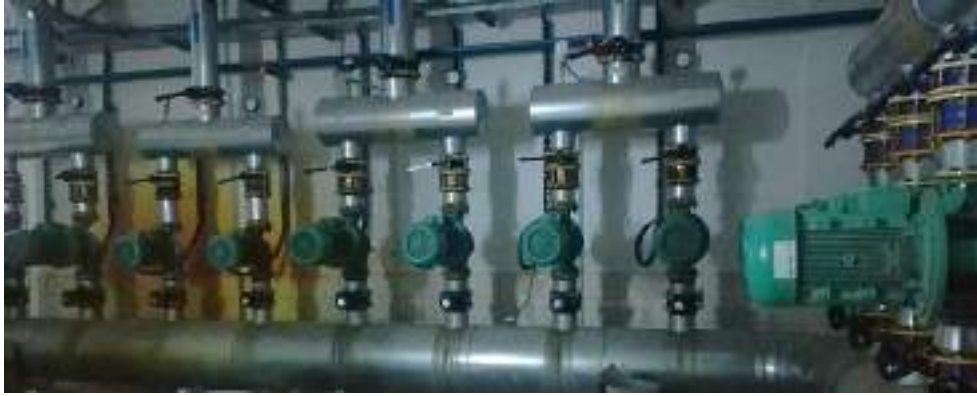
Fotoğraf 3. 59. Yalıtımsız Vana Görünümleri
