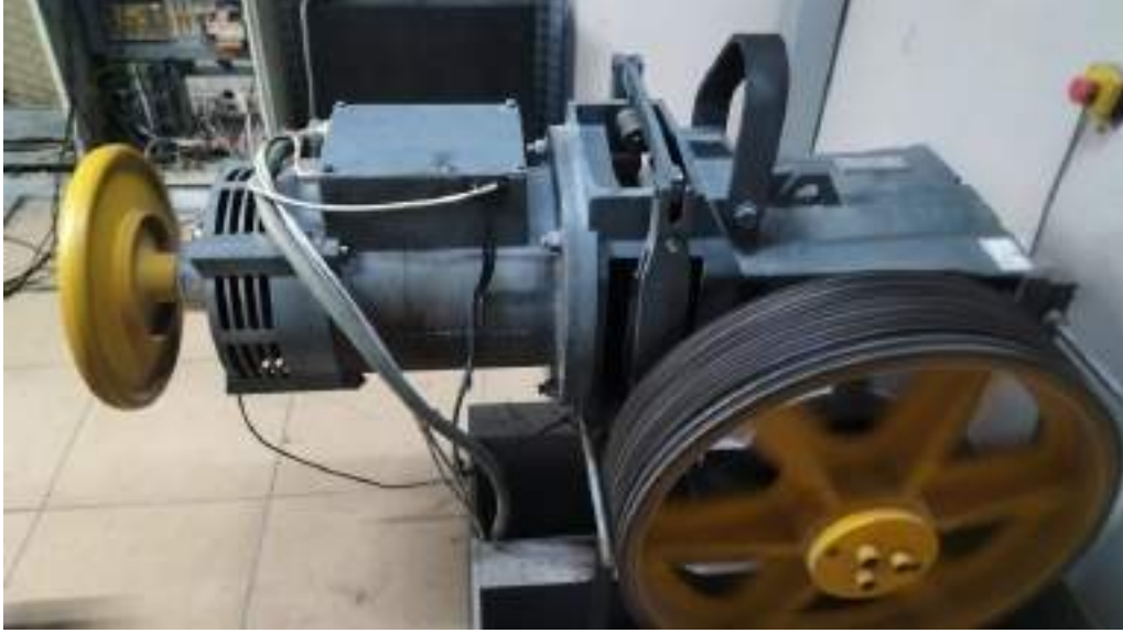
Fotoğraf 3. 97. Asansör Motoru
