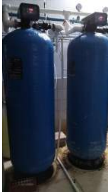
Fotoğraf 3. 44. Su Yumuşatma Cihazı Görünümü
