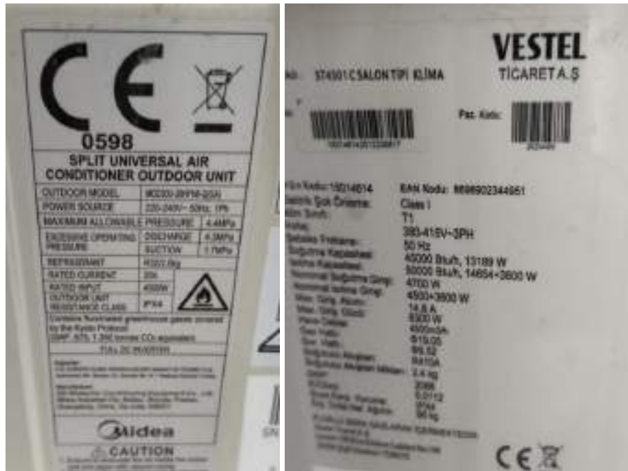
Fotoğraf 3. 53. Dış Ünitelerin Etiket Bilgileri
