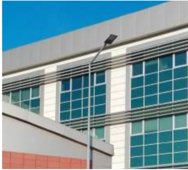
Fotoğraf 3. 103. 100W LED Sokak Tipi Aydınlatma Armatürleri
