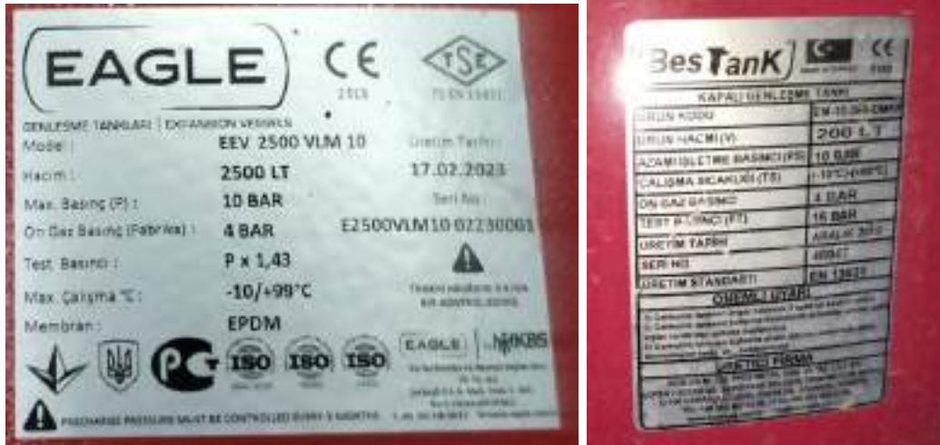
Fotoğraf 3. 40. Genleşme Tankı Etiket Bilgileri
