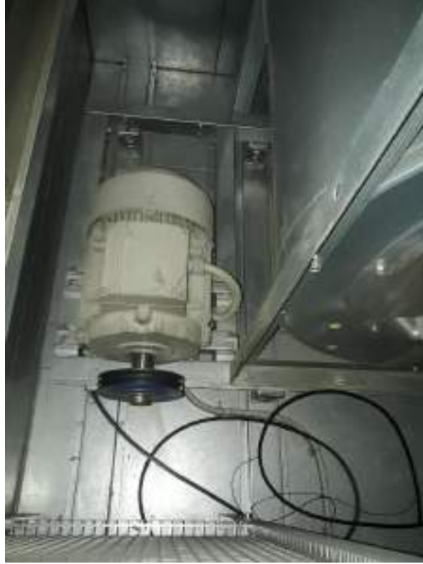
Fotoğraf 3. 90. EA-8 Aspiratör Motoru (Kayışı Kopmuş)
