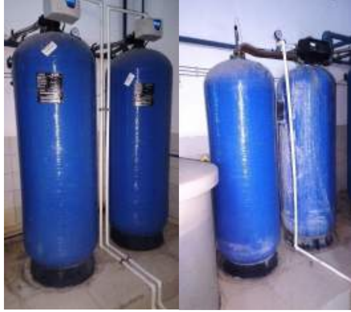
Fotoğraf 3. 43. Aktif Karbon Filtresi Görünümü
